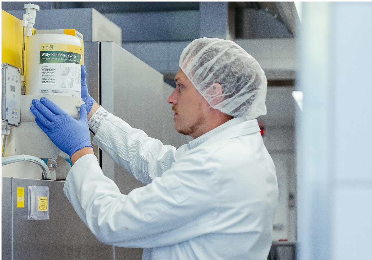
Foto: Der innovative Pulverreiniger wird leitwertgesteuert in den Reinigertank der Spülmaschine dosiert. Die Mehrweg-Kartuschen werden von Witty zurückgenommen, gereinigt und wieder befüllt.
